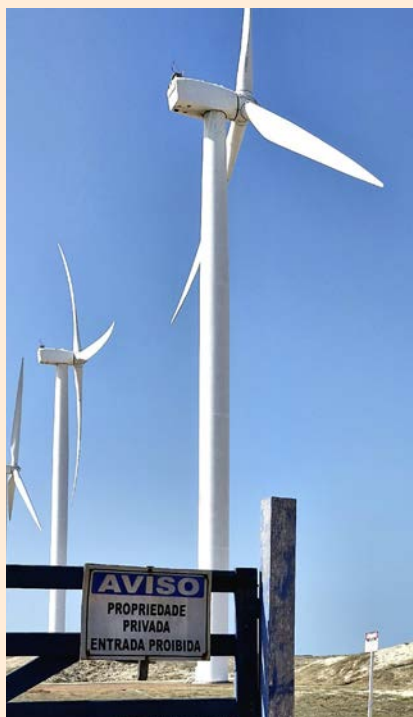
Usina Eólica Icarazinho, em Amonatada, Ceará. Construída em área de dunas. Dificulta acesso a locais sagrados e de práticas tradicionais, como cemitério e currais de pesca.
